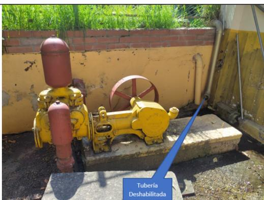
Foto No. 7. Tubería deshabilitada del aljibe aj-01-0095
